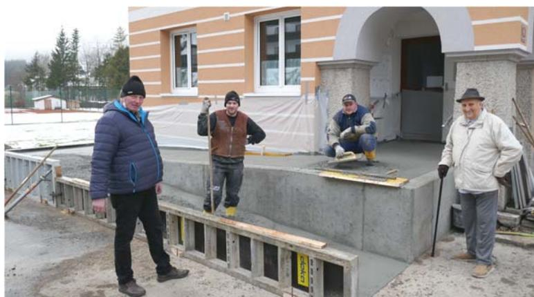
Die Rampe wurde mit einer Breite von 1,20 m und einem maximalen Gefälle von 6 % komplett in Massivbauweise errichtet. Der Oberflächenbelag wurde als Besenstrich ausgeführt. Um einer möglichen Eisbildung in der kalten Jahreszeit entgegen zu wirken, wurde ein elektrisch betriebenes Heizkabel in die Rampe eingelegt.
